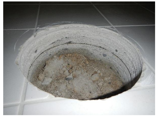
Rakennevaas AP4: Alapohja on maanvastainen.
