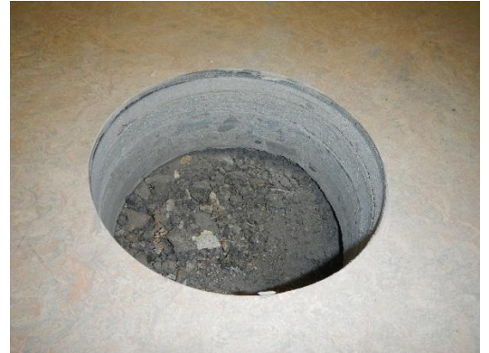
Rakenneavaus VP7: Välipohjan ylälaatan rakennekerrokset.
