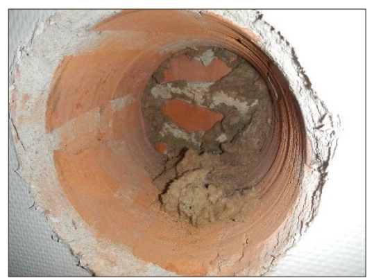
Rakenneavaus US4: Ulkoseinän sisäkuoren rakennekerrokset.
