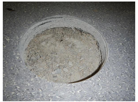
Rakenneavaus VP1: Välipohjan tojalevyssä ei ole viitettä vauriosta.
