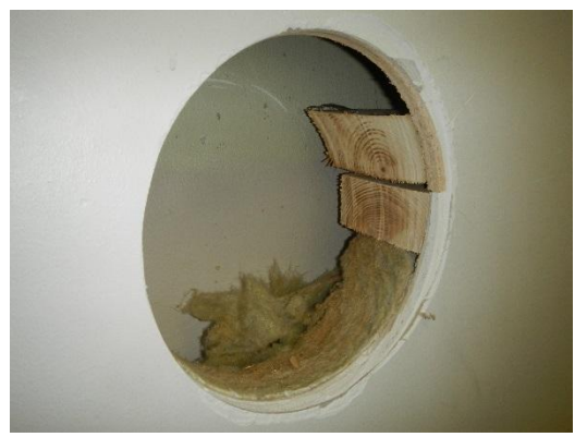
Rakenneavaus US8: Ulkoseinä on lisälämmöneristetty sisäpuolelta.
