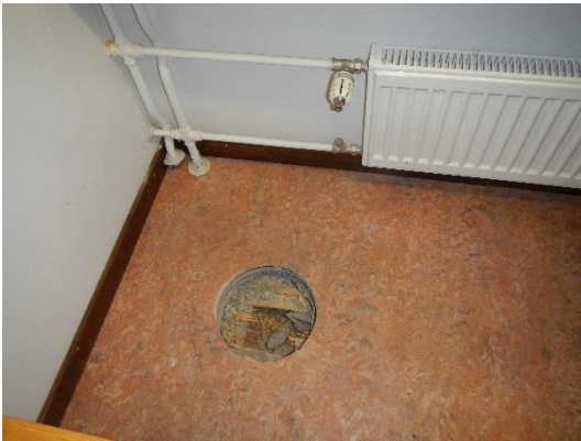
Rakenneavaus VP3: Sijainti hautausasioiden toimistossa ulkoseinän läheisyydessä.
