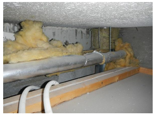
Rakenneavaus VP2: Näkymä kotelolaatan kotelotilaan. Putkieristyksissä on käytetty runsaasti mineraalivillaa.
