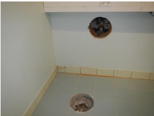
Rakenneavaukset AP1 ja US1: Sijainti alakerran kerhuhuoneessa 024.
