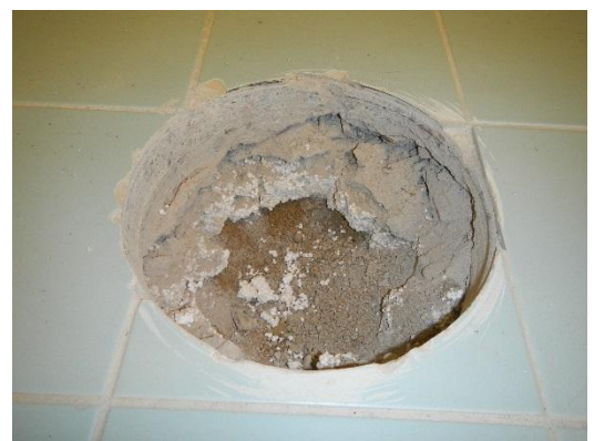
Rakenneavaus AP1: Alapohja on maanvastainen.
