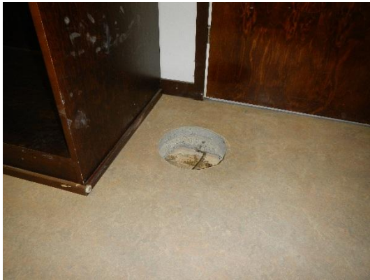
Rakenneavaus VP5: Sijainti aulassa 201 seurakuntasaliin 1 johtavan oven edustalla.
