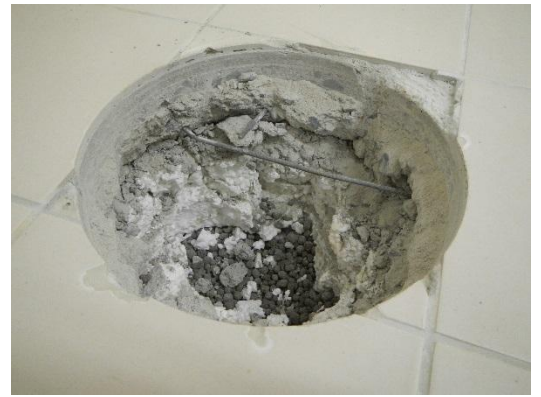
Rakennevaas AP2: Alapohja on maanvastainen.
