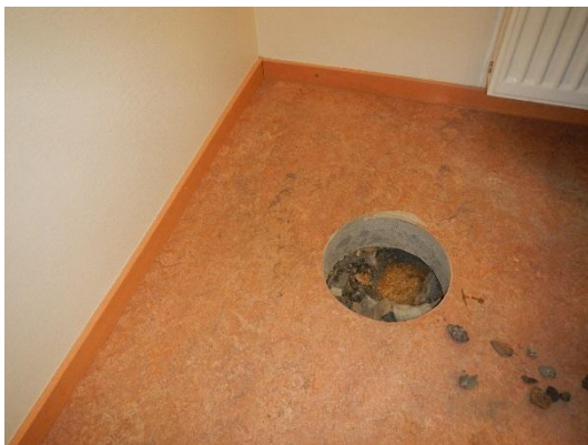
Rakenneavaus VP6: Sijainti isännöitsijän huoneessa ulkoseinän läheisyydessä.
