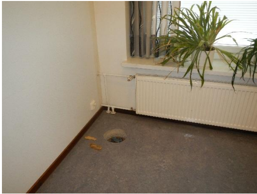
Rakenneavaus VP4: Sijainti seurakuntasalissa 1 ulkoseinän läheisyydessä.
