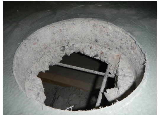
Rakenneavaus VP2: Kotelolaatan ylälaatta.
