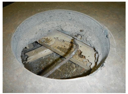
Rakenneavaus VP5: Välipohjan ylälaatan rakennekerrokset.
