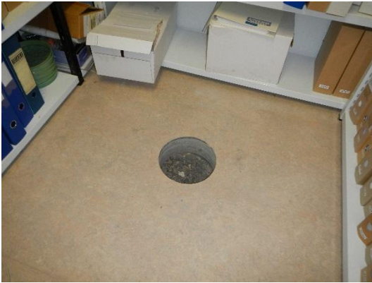
Rakenneavaus VP7: Sijainti taloustoimiston varastossa.
