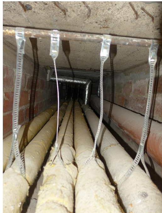
Rak-kuva 4 Vuonna 1954 rakennetun osan kellarikäytävän alla kulkee putkikanaali.
