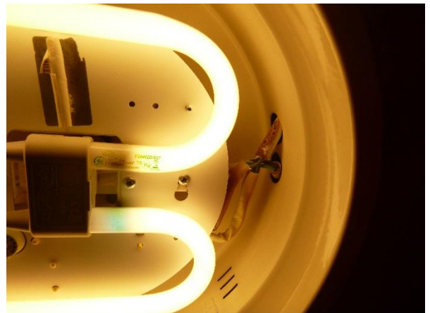
S-kuva 2 Kaapeliläpivientien palokatkot ovat puutteelliset.
