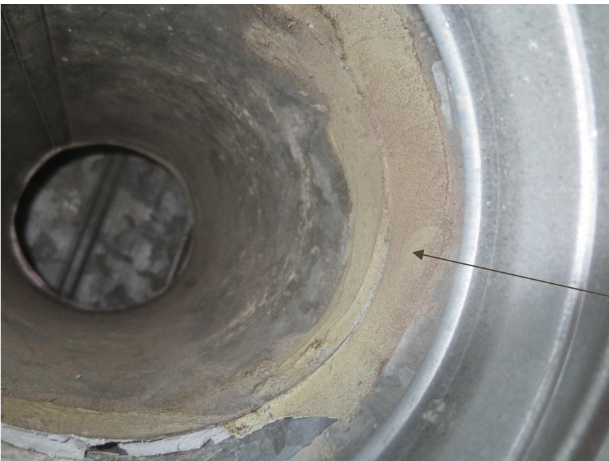
Kuva 12. Sakariston poistoilmahormin tiivistysmassassa sisältää asbestia .
