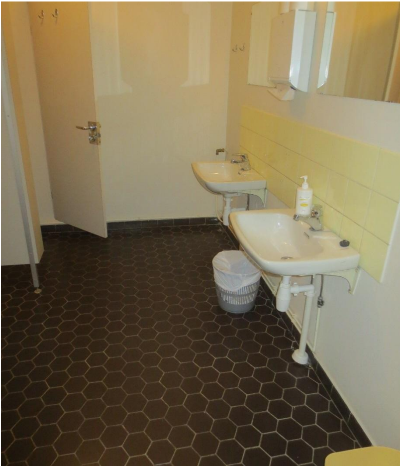
Kuva 3. WC-tilojen seinän ja lattian laattojen sauma- ja kiinnityslaasteissa ei havaittu asbestia.
