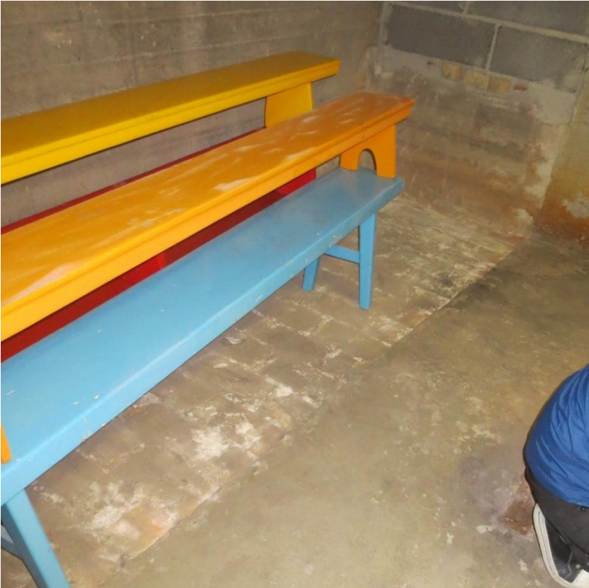
Kuva 11. Lämmönjakohuoneen puretussa savusolan/kanavan jäänteissä ei ole asbestia. Lattialaatan pinnassa ei ole asbestia. Lämmönjakohuoneen lattian betonissa ei havaittu öljyä.
