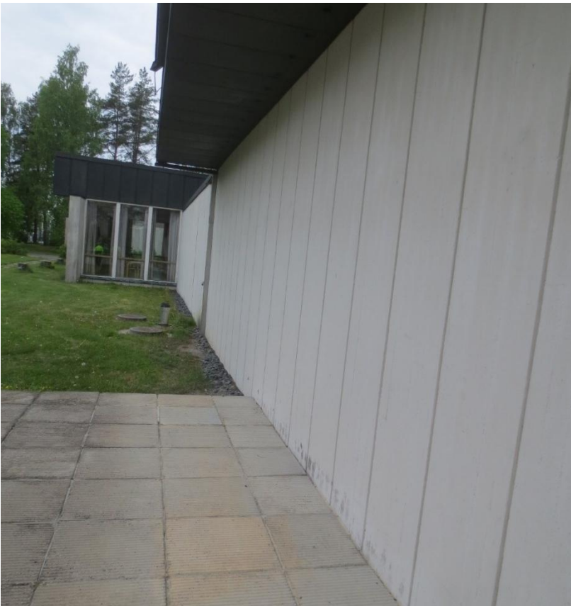
Kuva 8.. Ulkoseinämaali ei sisällä asbestia.
