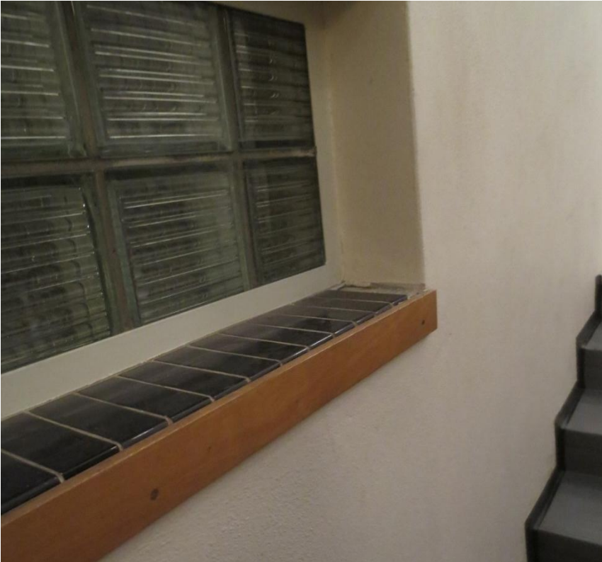
Kuva 7.. 1960-luvun osan ikkunapenkin saumaus- ja kiinnityslaasti ei sisällä asbestia. Lasitiilen saumausmassa ei sisällä asbestia.
