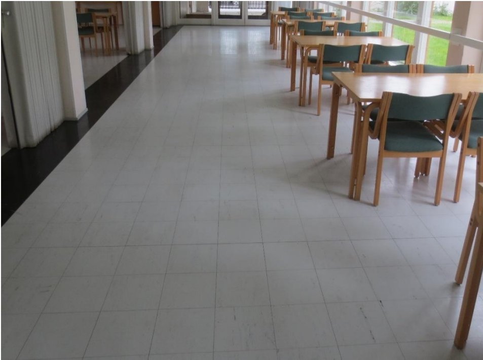
Kuva 1. Salitilan lattiassa on asbestipitoinen Finnflex-laatta , joka on liimattu asbestipitoisella mustaliimalla .
