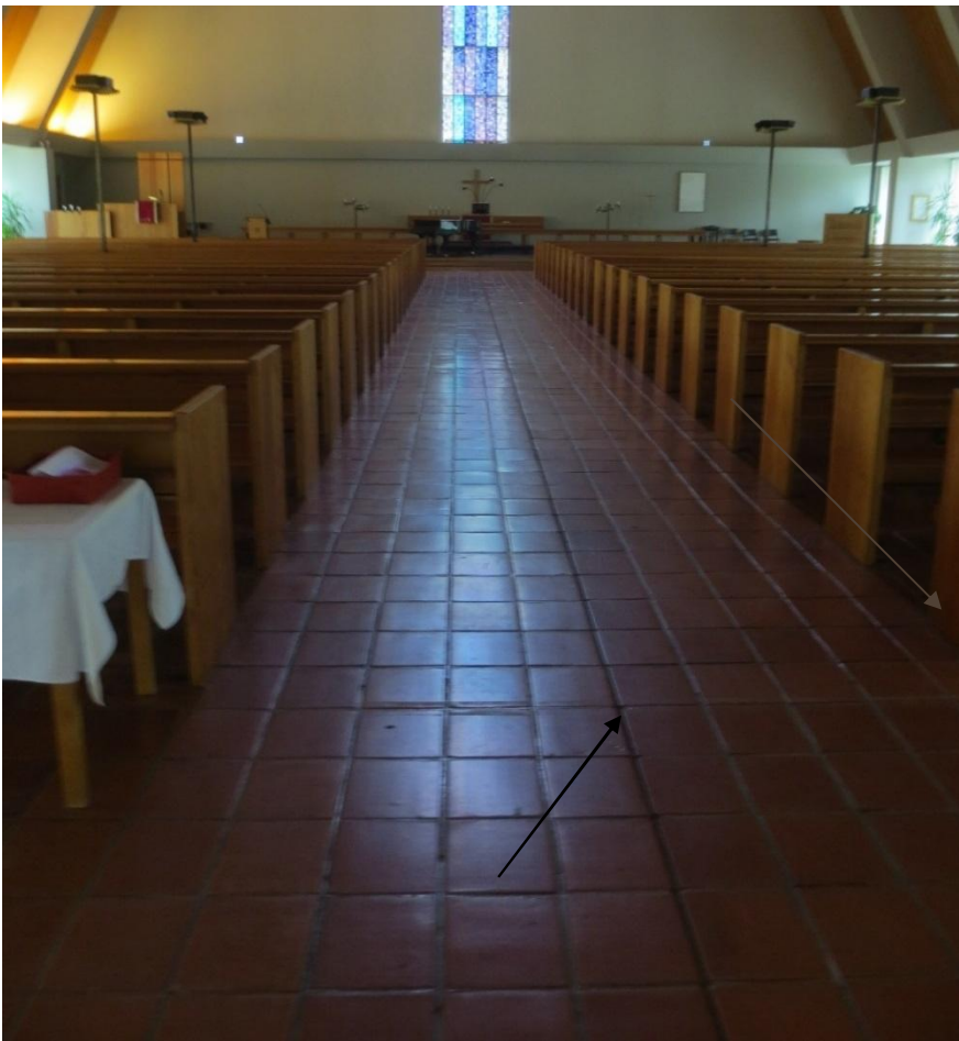
Kuva 2. Kirkon tiililaatta lattian lattiasauman elastisessa saumamassassa on PCB-yhdisteitä yli vaarallisen jätteen raja-arvon . Tiililaatan sauma- ja kiinnitysلاستissa ei havaittu asbestia. Kirkon penkkien lakassa ei havaittu PCB-yhdisteitä.
