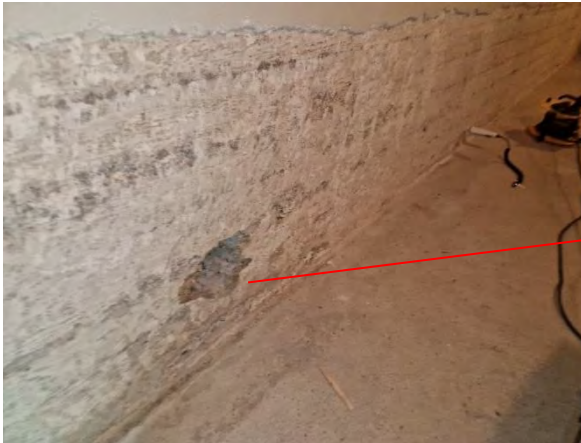
Kuva 21 Sakaristosiiven kellarin käytävälle 0.31 maanvastaiseen seinään tehty rakenneavaus MVS1.
