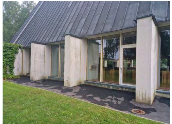
Kuva 11 Sisäpihalle kirkkosalin viereen on lisätty sadevesikaivoja ja piha-alueetta on asfaltoitu.
