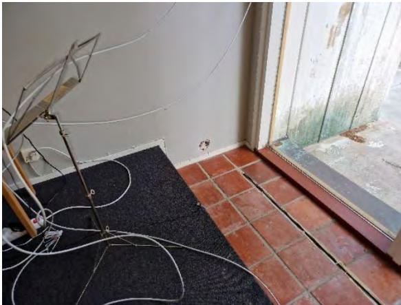
Kuva 70 US3 tehtiin kirkkosalin pohjoisen puolei- seen ulkoseinään. Rakenneavauspis- teessä ei kuitenkaan havaittu läm- möneristemateriaaleja (kohdassa paksu betonirakenne).
