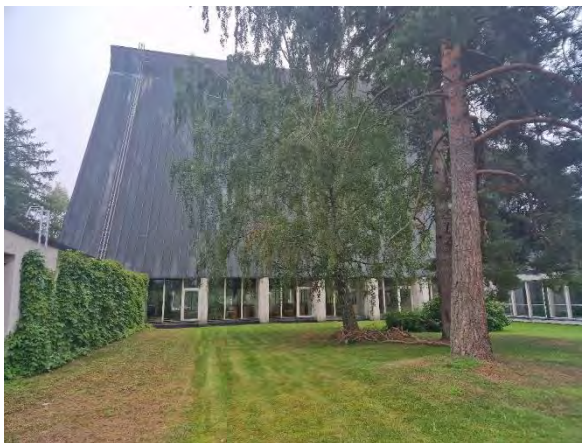
Kuva 4 Yleiskuva kirkkorakennuksesta sisäpihan puolelta.
