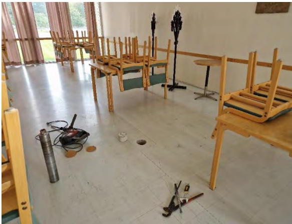
Kuva 40 Rippikoulusalin 1.11 maanvastaiseen leca-soraeristeeseen alapohjaan tehtiin yksi rakenneavaus.
