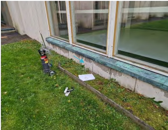
Kuva 72 Merkkiaineen laskupaikka esitetty sinisellä nuolella (käytävä 1.17).
