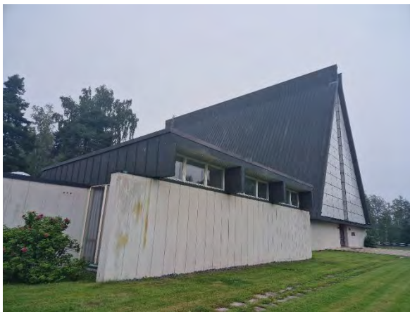
Kuva 2 Yleiskuva etelän puoleisesta julkisivusta.
