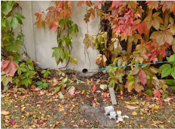
Kuva 68 Rakenneavauspiste US2 Sakaristosii- ven ulkoseinän alaosa.
