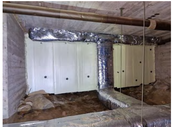
Kuva 18 Ryömintätilassa maanvastaiset seinät on lämmöneristetty sisäpuolelta XPS-eristelevyillä.
