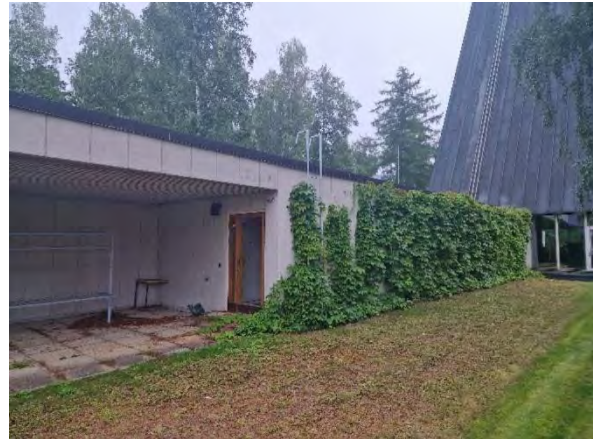
Kuva 59 Yleiskuva Sakaristosiiven sisäpihan puoleisesta julkisivusta. Julkisivun pinnassa kasvaa köynnöskasvi.
