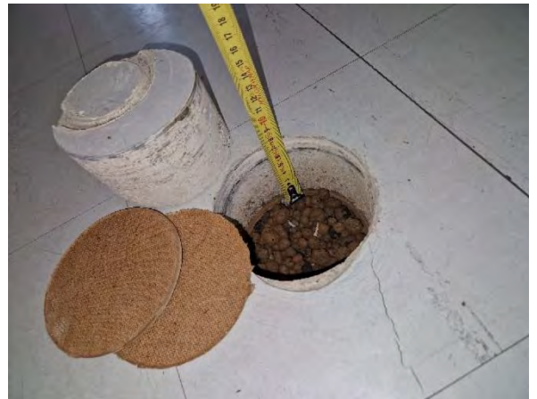
Kuva 41 Leca-soraeristeen ja betonilaatan välissä olevissa kovalevyissä ei havaittu aistinvaraisesti vaurioita.
