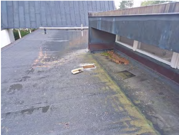
Kuva 97 Yläpohjan rakenneavaus YP1 käytävälle 1.17.
