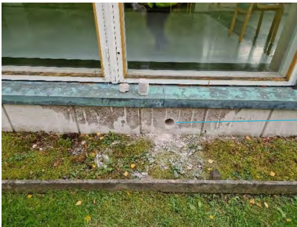
Kuva 66 Rakenneavauspiste US1 rippikoulusiiven ulkoseinässä.
