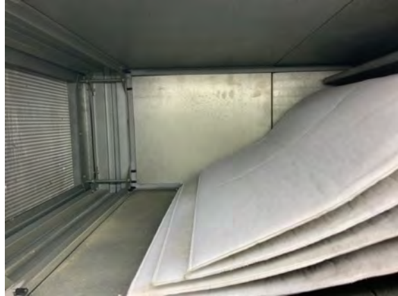
Kuva 8 Suodatinkammiossa on pölyä ja suodatimet ovat vaakamalliset.
