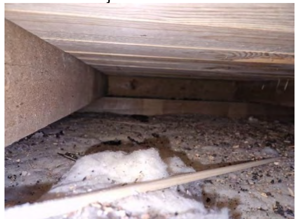
Kuva 100 Rippikoulusiiven yläpohjan tuulettumis-edellytyksissä ei todettu puutteita.
