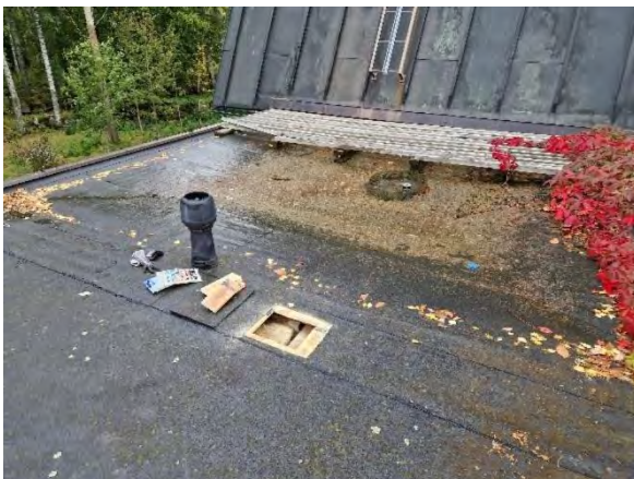
Kuva 105 Kuva sakaristosiiven yläpohjaan tehdystä rakenneavauksesta YP3.
