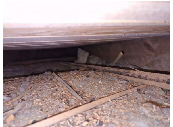
Kuva 108 Sakaristosiiven yläpohjan tuulettumisedellytyksissä ei todettu puutteita.
