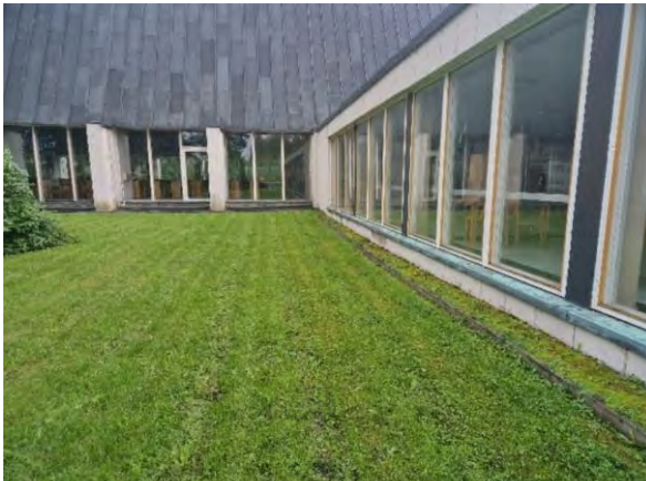
Kuva 10 Sisäpihan puolella on nurmikkopinta. Rippikoulusiivessä sokkeliä vasen on hieno maa-aines.
