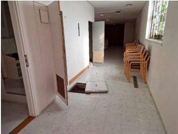
Kuva 80 Kulku korotuslattian alle tapahtuu urkutilan takana lattiassa olevasta luukusta.
