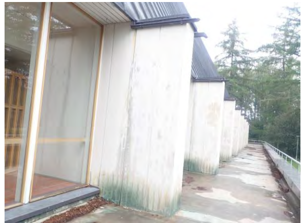
Kuva 114 Kirkkosalin kuparikatteelta sadevedet ohjautuvat suoraan maahan tai sadevesikouruihin, jotka johtavat sadevesiä julkisivujen pintaan.
