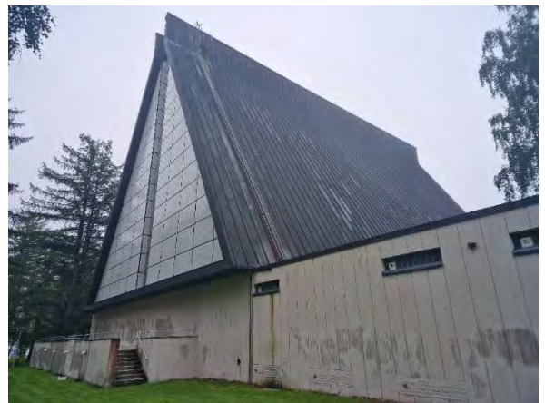
Kuva 3 Yleiskuva pohjoisen puoleisesta julkisivusta.
