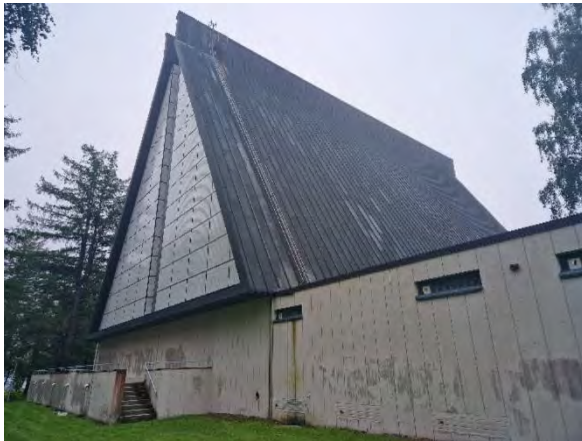
Kuva 56 Yleiskuva pohjoisen puoleisesta julkisivusta.
