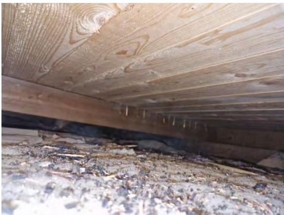
Kuva 99 Rippikoulusiiven yläpohjan tuulettumis-edellytyksissä ei todettu puutteita.
