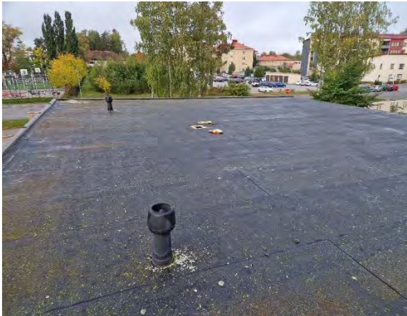
Kuva 95 Yleiskuva rippikoulusalin 1.11 vesikattosta.
