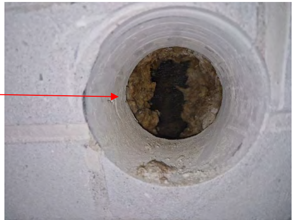
Kuva 24 Kuurimuurauksen takana on mineraalivillalämmöneriste ja bitumisively.
