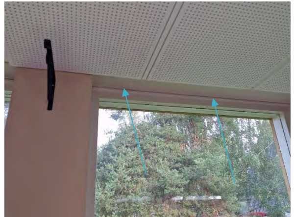
Kuva 71 Ikkuna- ja ulkoseinä-/ yläpohjarakentei- den liittymissä on monin paikoin havait- tavissa ilmavuotojen aiheuttamia tum- mentumia.
