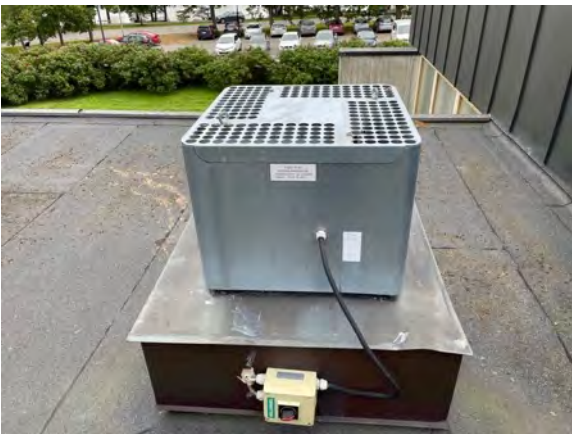
Kuva 15 Yleiskuva huippuimureista.
