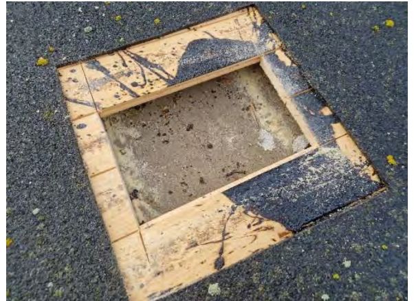
Kuva 102 Rippikoulusalin 1.11 yläpohja on suunnitelmien mukaisesti kevytbetonia.
