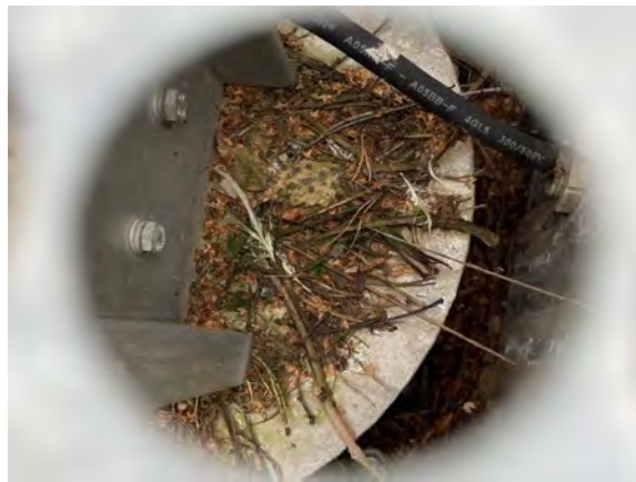
Kuva 16 Huippuimurin sisällä on epäpuhtauksia.
