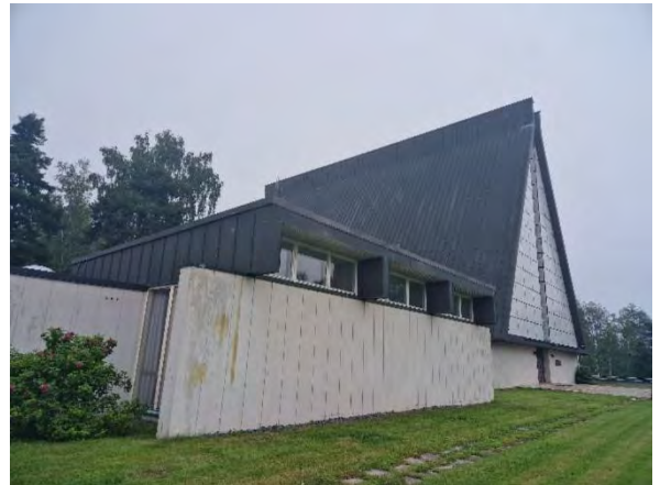
Kuva 57 Yleiskuva etelän puoleisista julkisivuista.
