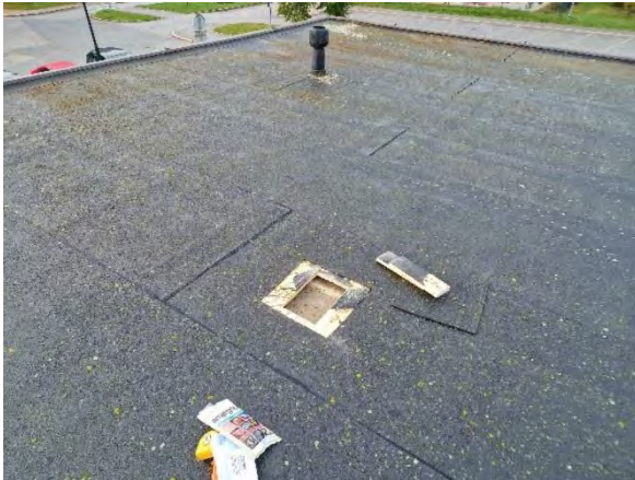
Kuva 101 Kuva rippikoulusalin 1.11 vesikattoon tehdystä rakenneavauksesta YP2.
