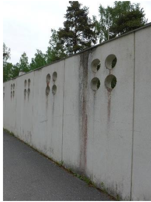
Kuva 5 Yleiskuvaa länsisivun tukimuurista
