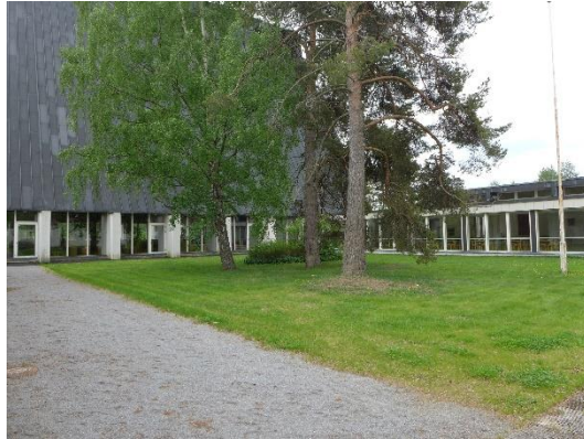
Kuva 1 Yleiskuvaa kirkon sisäpihalta
