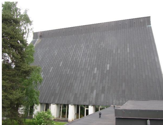
Kuva 27 Yleiskuvaa kirkon vesikatosta
