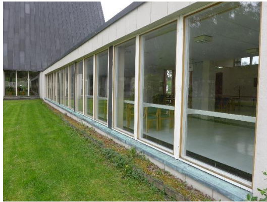
Kuva 21 Yleiskuvaa rippikoulusalin alkuperäisistä ikkunoista
