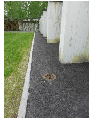
Kuva 4 Tontin sadevesien poistojärjestelmä on uusittu
