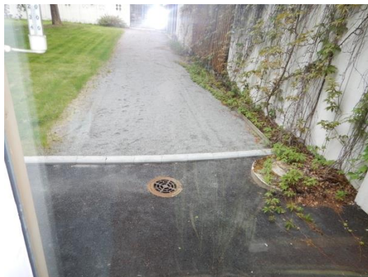
Kuva 41 Yleiskuva uusitusta sadevesikaivosta.
