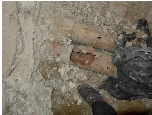
Kuva 3 Salaojat ovat alkuperäistä tiiliputkea
