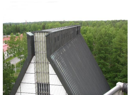
Kuva 28 Yleiskuvaa kirkon vesikatosta
