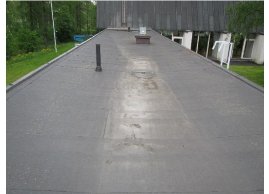
Kuva 30 Yleiskuvaa Sakastiosan vesikatosta
