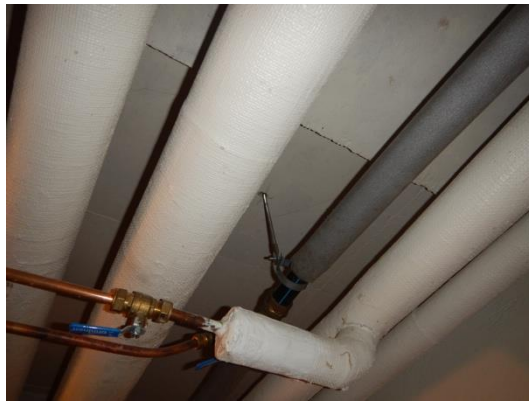
Kuva 45 Yleiskuva uusituista ja alkuperäisistä käyttövesiputkista.
