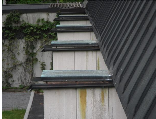
Kuva 29 Yleiskuvaa pilasteiden pellityksistä
