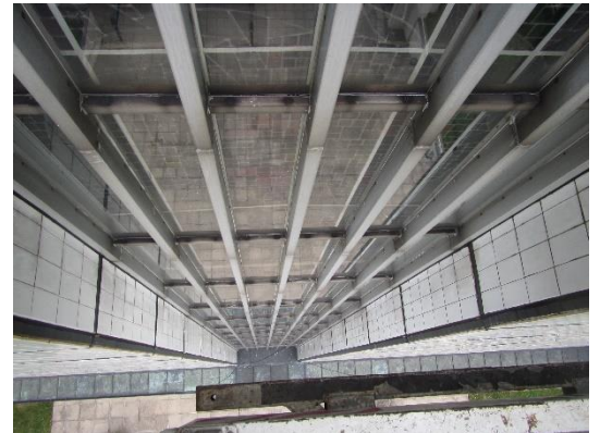
Kuva 24 Yleiskuvaa pohjoispäädyn taidelasi-ikkunasta
