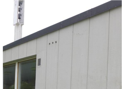
Kuva 36 Yläpohjan tuuletusaukkoja.
