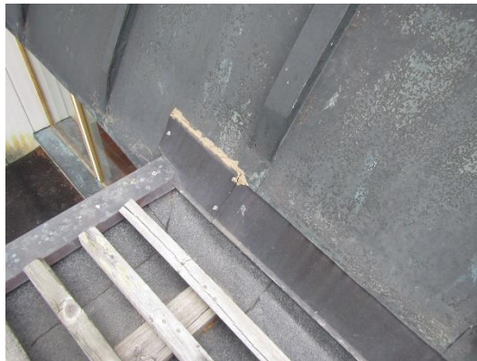
Kuva 33 Pellityksessä epätiiviyttä.
