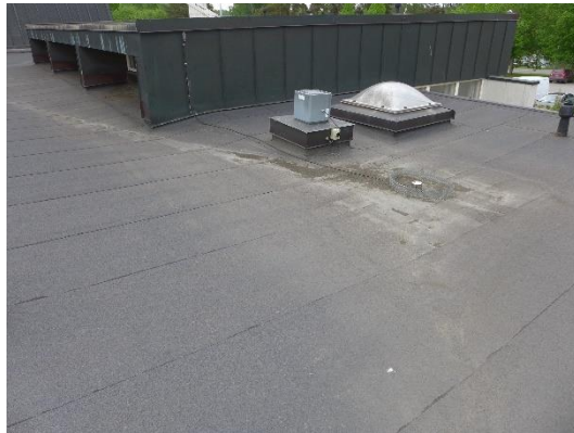
Kuva 37 Bitumikermikatteen läpivientejä.
