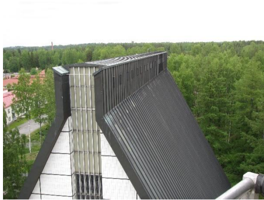
Kuva 28 Yleiskuvaa harjan pellityksistä
