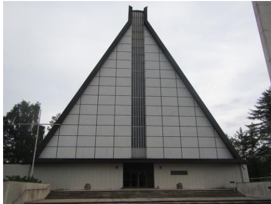
Kuva 1 Yleiskuvaa klinkkeripintaisesta julkisivusta.
