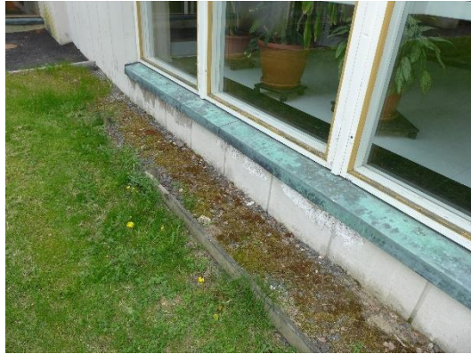
Kuva 9 Nurmialuetta ei ole erotettu sokkelista oikein.
