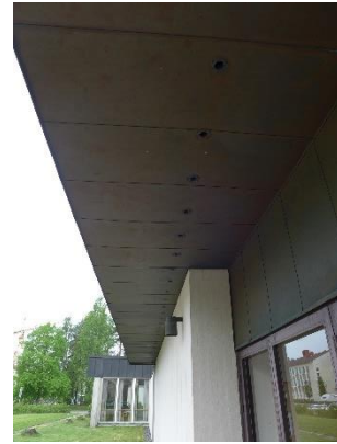
Kuva 10 Päätokolmioiden tuuletustilan tuuletusaukot.
