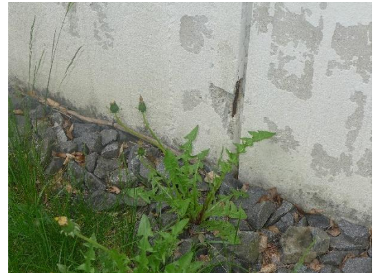
Kuva 6 Ulkoseinän teräskorroosiovaurio.
