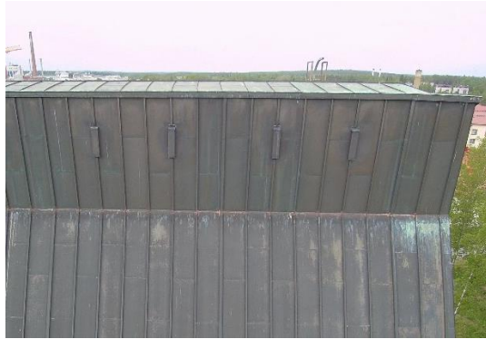
Kuva 35 Harjan tuuletusritilät.
