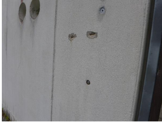
Kuva 21 Teräskorroosiovaurioita.
