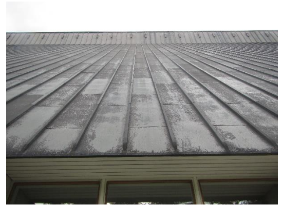
Kuva 29 Oksidikerroksessa kulumaa
