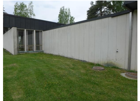
Kuva 2 Yleiskuvaa betonipintaisesta julkisivusta
