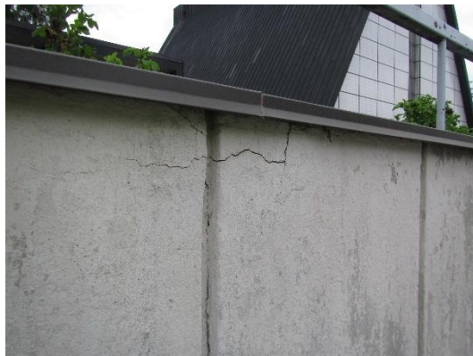
Kuva 19 Betonin halkeilua.
