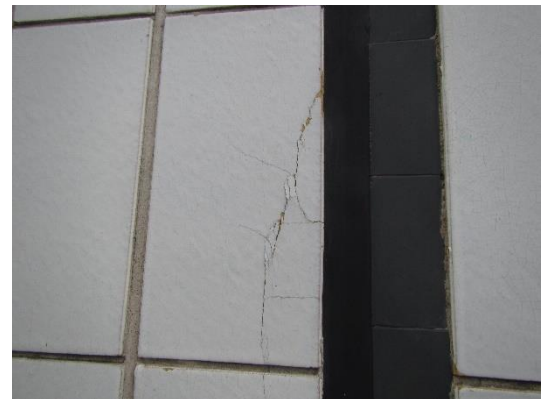
Kuva 12 Klinkkerilaatoissa halkeamia.
